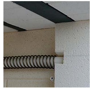
Dakconstructie volgens concept ROHDE
