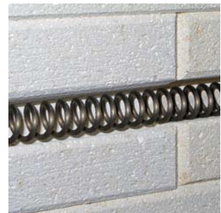
Spiralen in gleuven (KE-L en KE-N)
