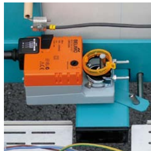
Toevoerschuif met motor (achteraf mogelijk)
