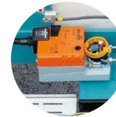
Zuluftklappe mit Stellmotor
